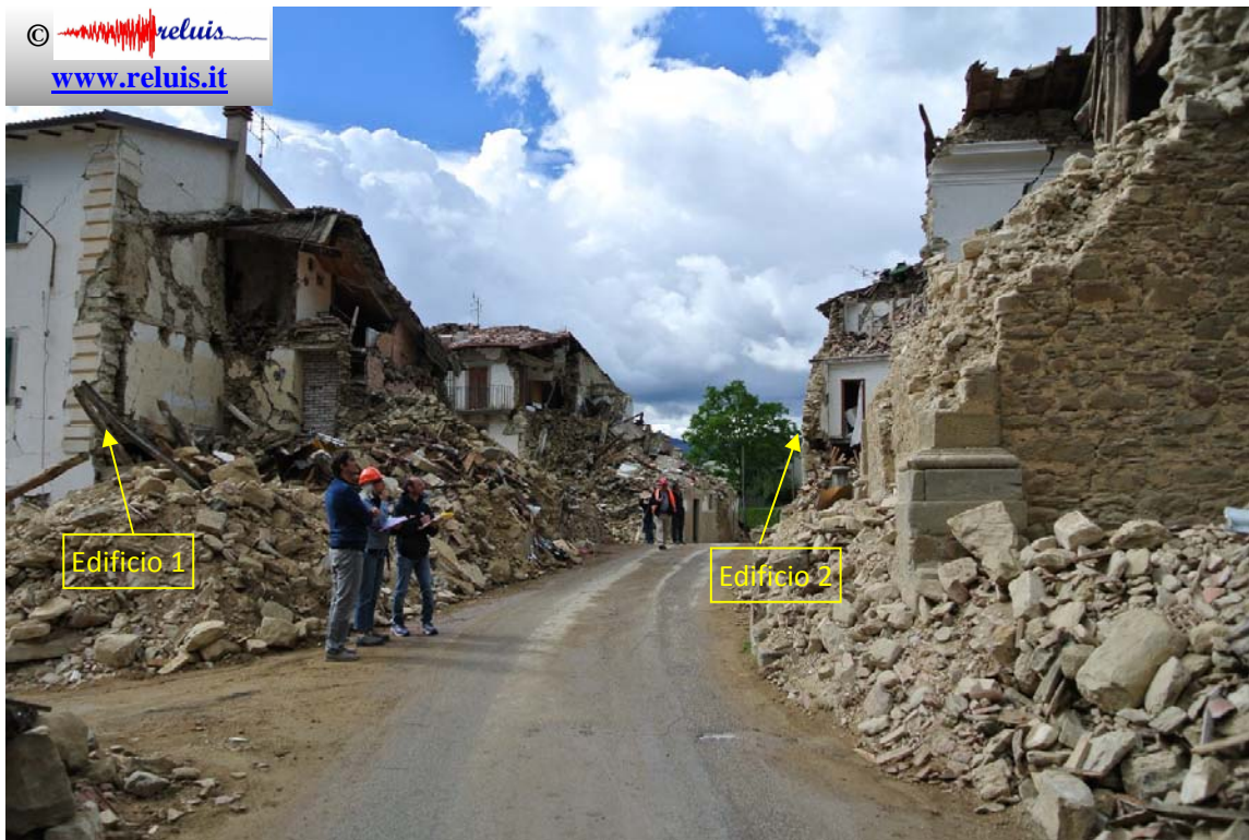
SP20 – Rio: Edifici e luoghi di culto collassati totalmente o parzialmente adiacenti alla SP20.
