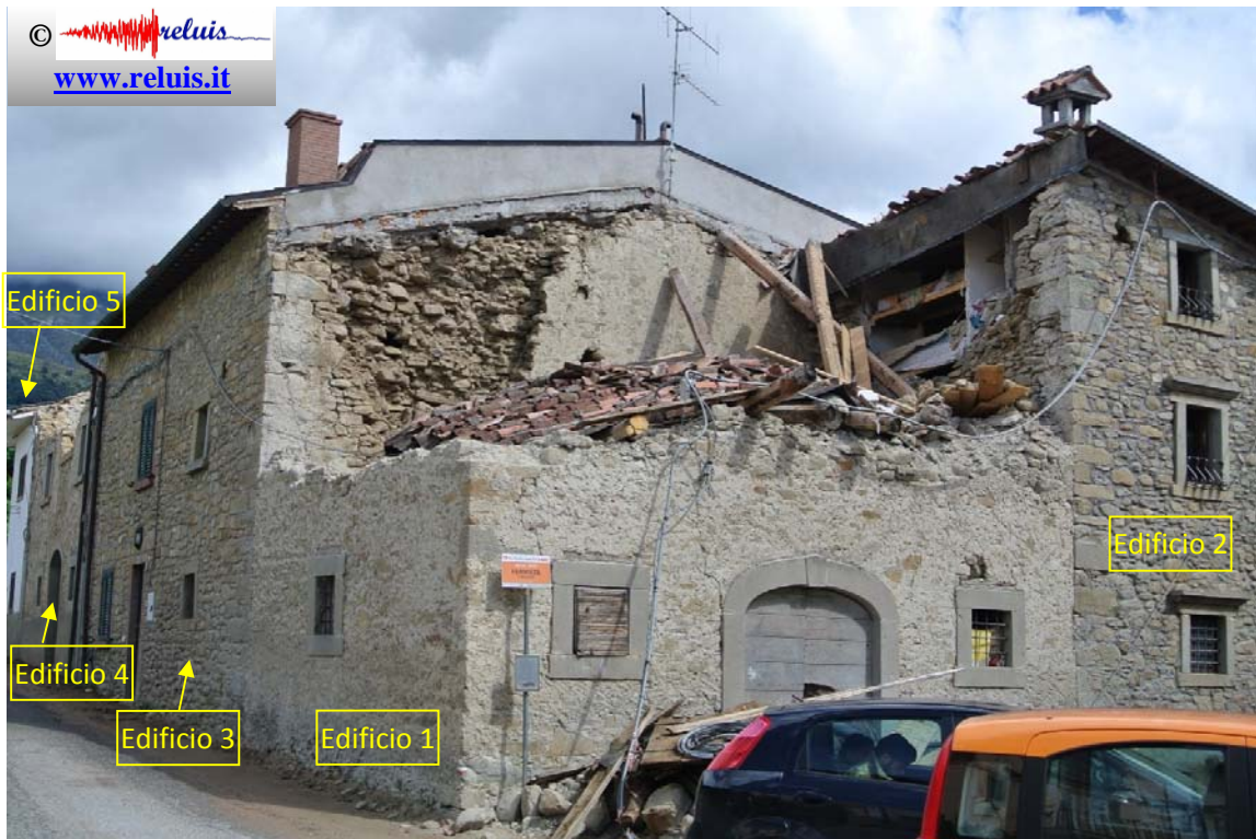
SP20–Cascello: Primo gruppo di edifici in aggregato adiacenti la SP20: parziale collasso degli Edifici 1 e 4.
