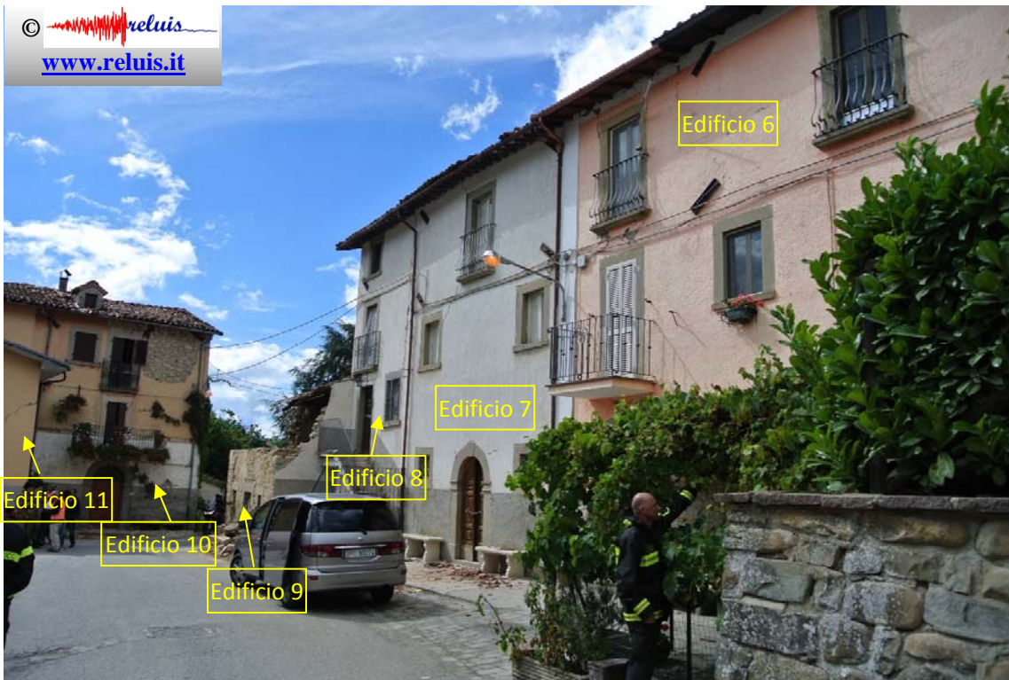
SP20–Casello: Secondo gruppo di edifici adiacenti la SP20: presenza di catene sugli edifici 6, 7, 8, 10.
