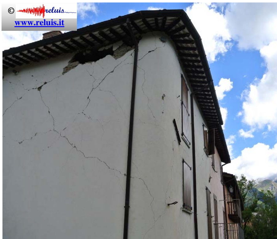
SP20–Retrosi: Lesioni diagonali nel piano per taglio-trazione ed evidenza della presenza di catene in acciaio.
