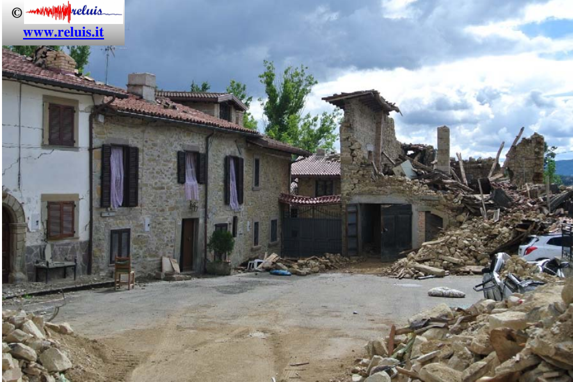
SP20 – Rio: Edifici in aggregato adiacenti alla SP20: evidenza di edifici collassati, edifici con fessurazione diagonale e presenza di catene.
