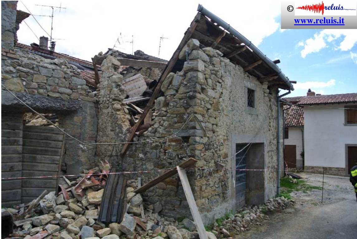
SP20-Prato: Collasso parziale edifici adiacenti la SP20.
