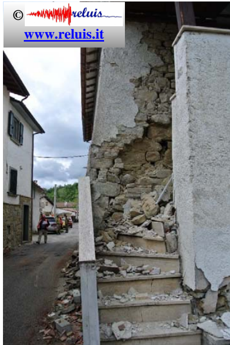
SP20 – Cossito: Evidenza di marcata fessurazione diagonale a taglio-trazione con espulsione del cantonale.
